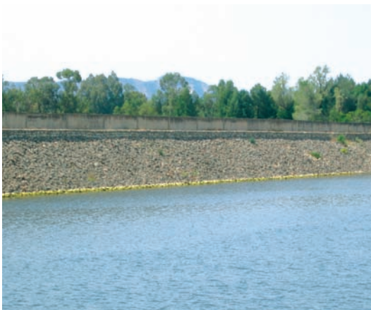
Barrage Bezirk: baisse du niveau de l'eau suite à la vidange des eaux du fond
