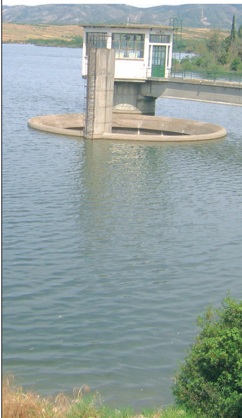
Vue du Barrage Bezirk
