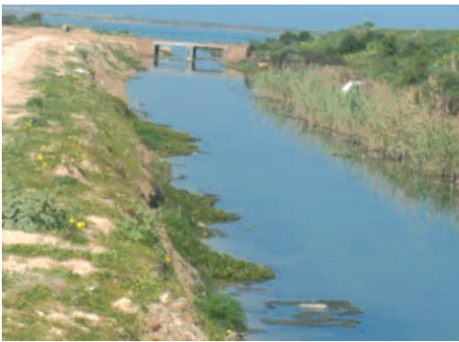
Vue de Sebkat Ariana ( canal de rejet)
